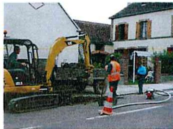
Réparation de fuite sur le réseau d'eau potable
